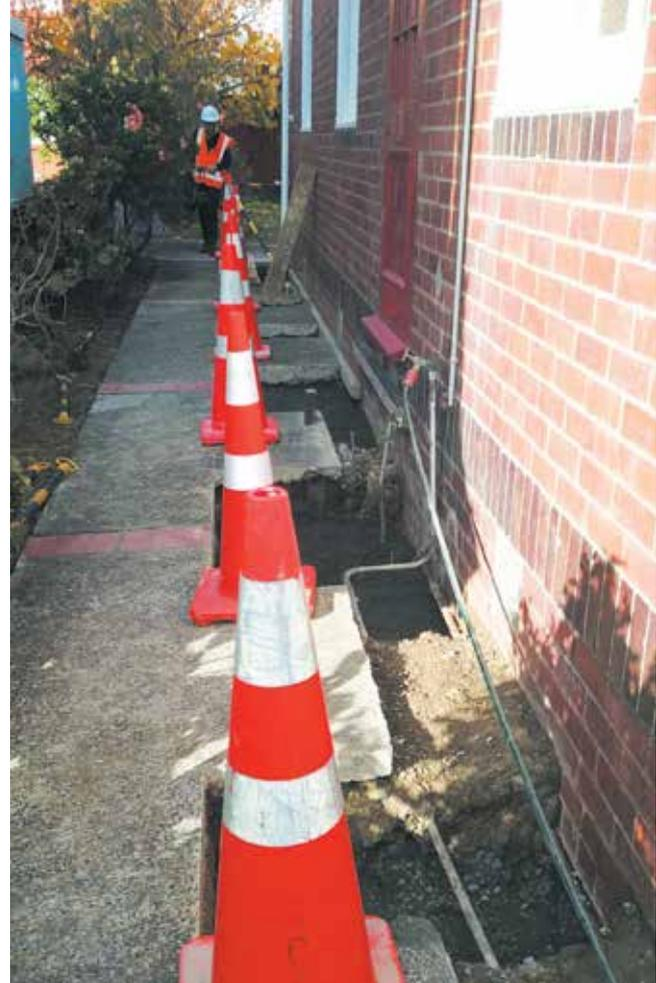
*Excavation work to pour concrete anchors for the prestressing cables.*
